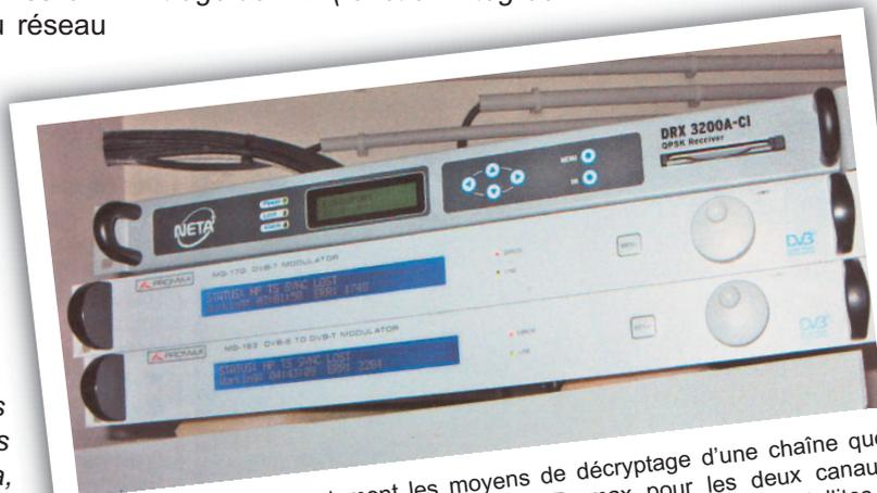
La solution intègre également les moyens de décryptage d'une chaîne que l'on aperçoit ici sur les transmodulateurs Promax pour les deux canaux COFDM (55 et 56) ayant été réglés sur le réseau pour les chaînes satellites.
