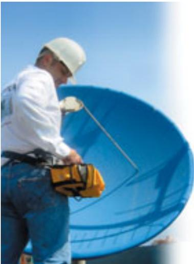
Mis à part les éléments et pièces mécaniques, la parabole est formée de deux parties clairement différenciées : le réflecteur et le LNB.
